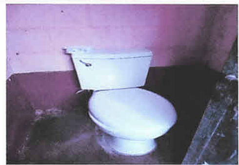
FOTO 6: Sustrucion de 2 Sanitarios
