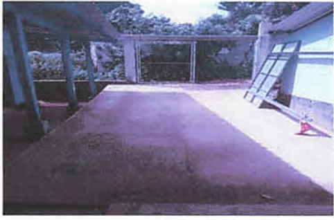
FOTO 1: Sustrucion de Porton de malla en mal estado
