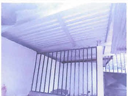
FOTO 5: Ampliacion de Cocina
