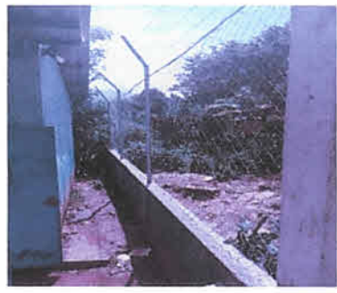
FOTO 3: Sustrucion de muro
